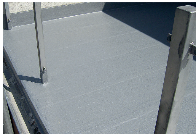
• Dvignjenih gradbenih elementov
